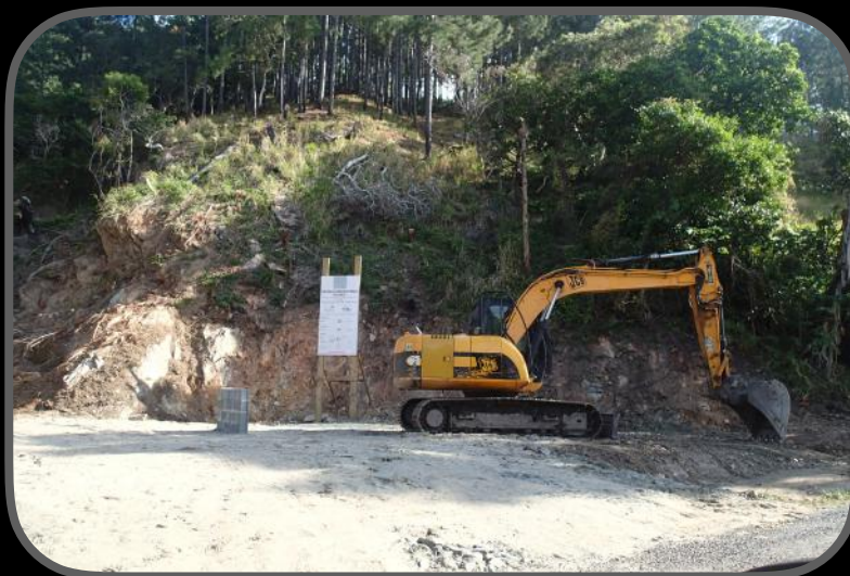
« Premières pierres » de la future centrale
